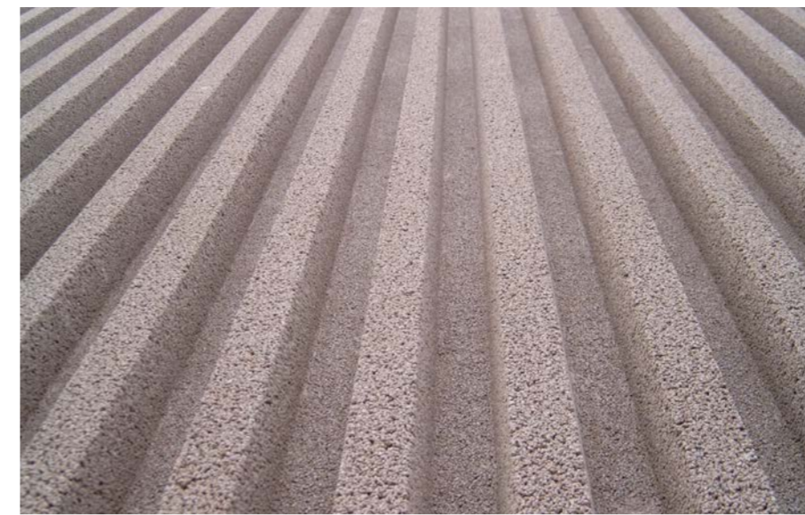
Ruwe geluidsdempende wanden langs het spoor
