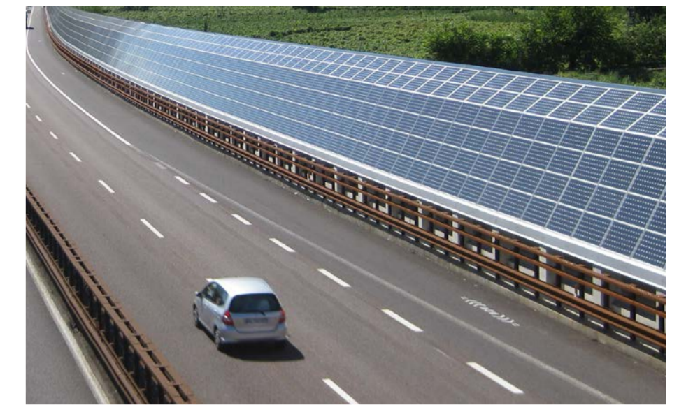
Zonnepanelen verwerkt in een geluidsscherm
