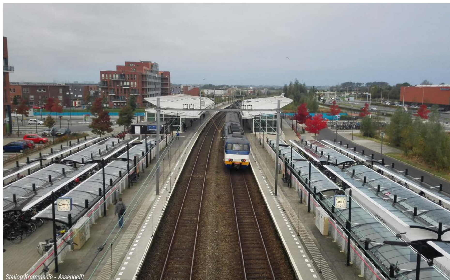
Statiop Krommenie - Assendelft
