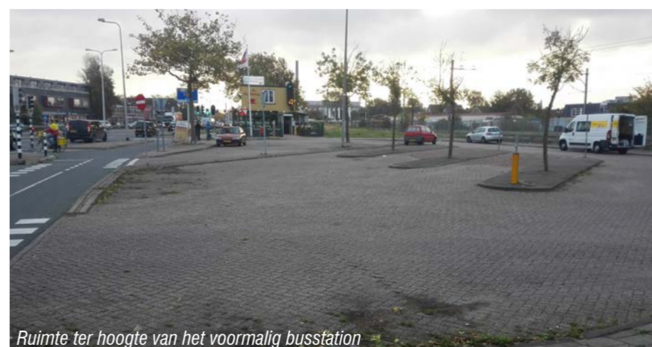
Ruimte ter hoogte van het voormalig busstation
