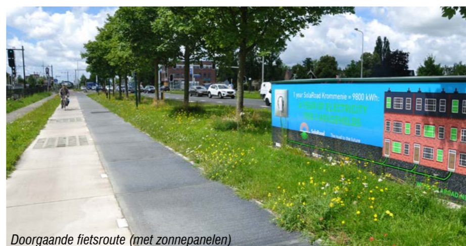
Doorgaande fietsroute (met zonnepanelen)
